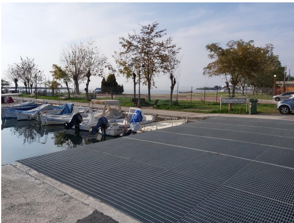
Φωτ. 6: Αγωγός ομβρίων υδάτων βορείως της μαρίνας εκτός της χερσαίας ζώνης
