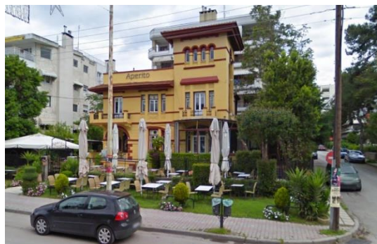
1. Αστικό κτίριο στην οδό Πλαστήρα 69
