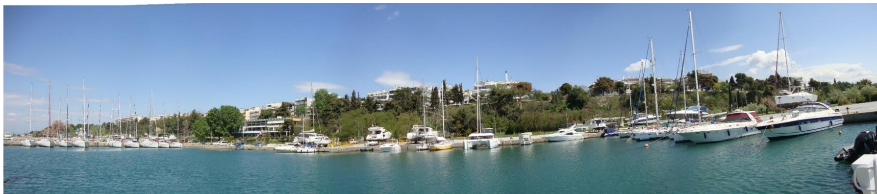
Φωτ. 2: Άποψη βορείου τμήματος μαρίνας από τον προβλήτα ΖΗ
