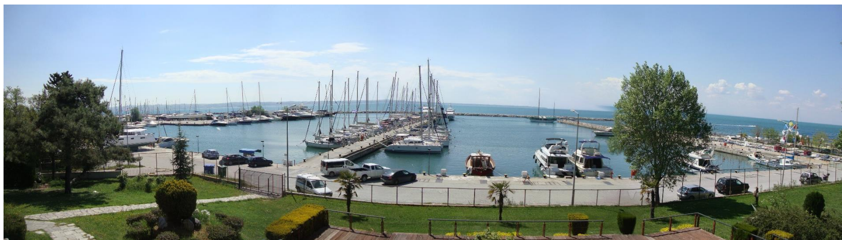
Φωτ. 3: Άποψη χερσαίας και θαλάσσιας περιοχής της μαρίνας από το κεντρικό κτίριο
