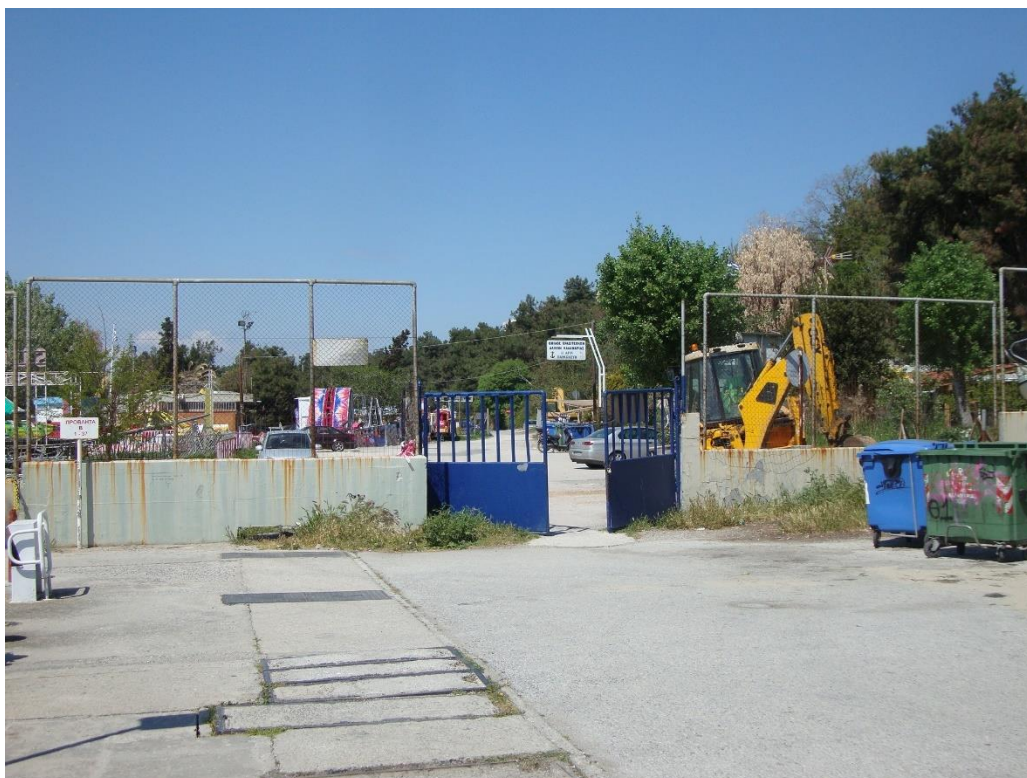
Φωτ. 5: Βοηθητική είσοδος μαρίνας στο βόρειο τμήμα της χερσαίας ζώνης
