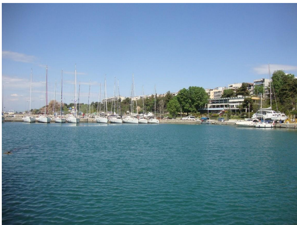
Φωτ. 7: Άποψη βορειοδυτικού τμήματος μαρίνας, κεντρικό κτίριο
